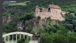
Parkplatz Burg Runkelstein 46°30'55.8"N, 11°21'30.8"E
